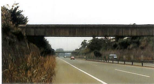
野火止用水水路橋
